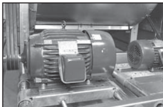
LRW通风机电动机 (图示中安装了可选件—辅助电动机)
